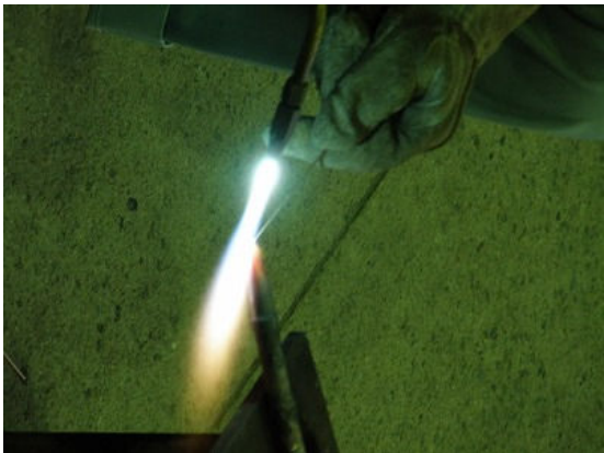
銅管溶接と銅管加工
