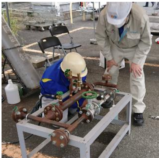
配管漏えい時の措置実習
