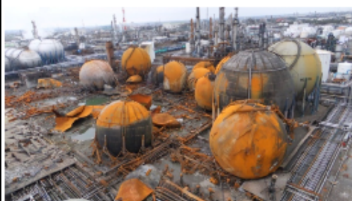
火災後の発災施設
